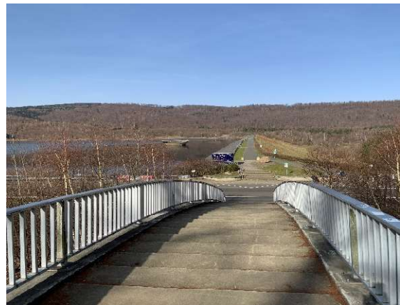
Blick auf die Staumauer der Innerstentalsperre
